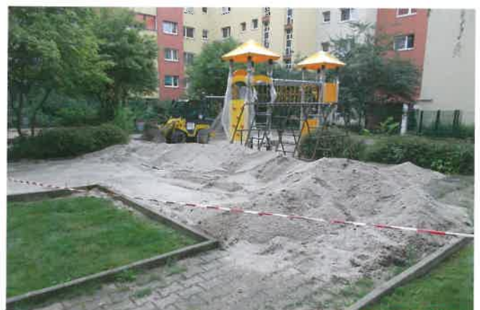
während der Bauphase
