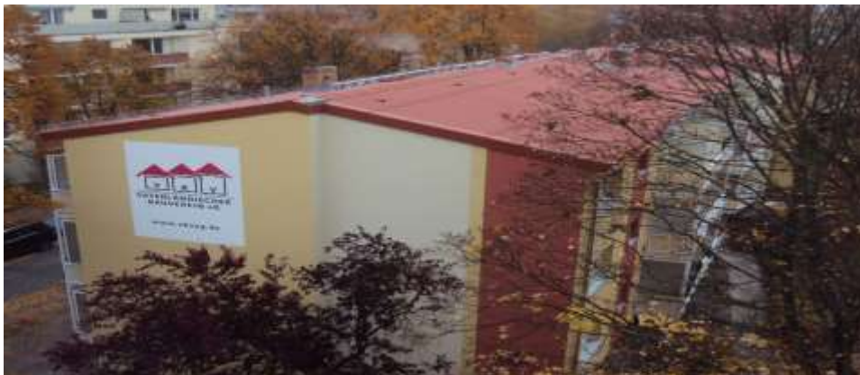
Giebel Breitenkopfstraße 57 nach der Maßnahme
